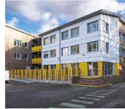
NANTES RÉSIDENCE SOCIALE EN HABITAT MODULAIRE 55 logements sociaux Architecte : Moon architecture Gestionnaire : Les Eaux Vives EMMAÛS Agence de proximité : Goudy
