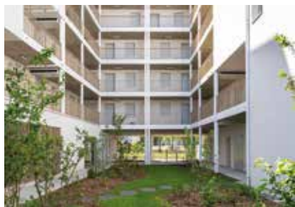
NANTES RESPIRATIONS 34 logements sociaux acquis en VEFA Architecte : PADW Promoteur : Nexity Agence de proximité : Watteau
