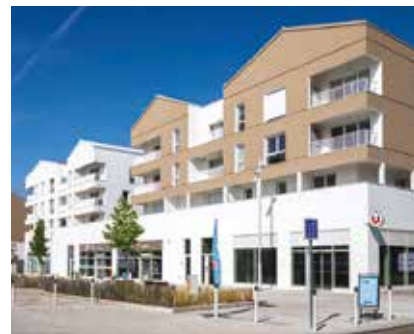
LES SORINIÈRES L'ESSOR 14 logements sociaux acquis en VEFA Architecte : Huca Promoteur : Ataraxia Agence de proximité : Goudy
