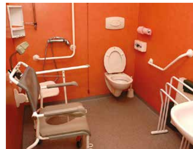
Exemple d'aménagement PMR dans une salle de bain NMH →
