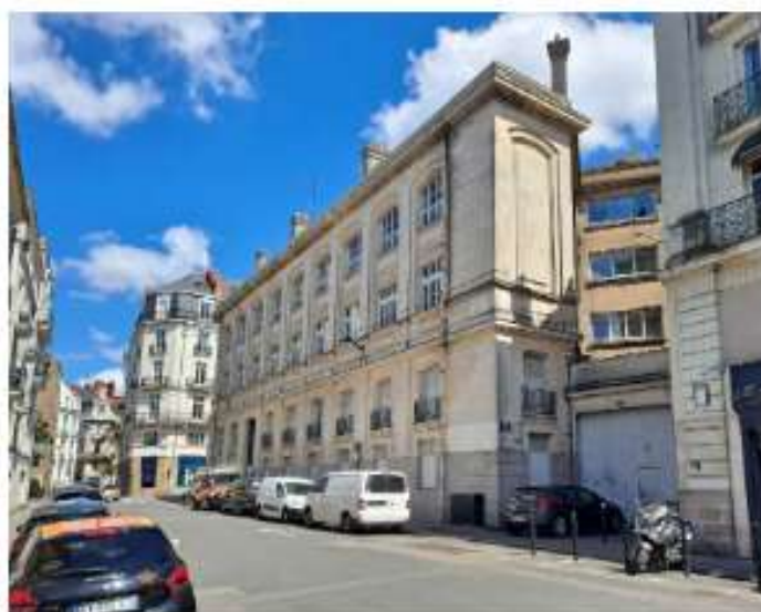
Figure 2 : Façades protégées du Crédit Municipal
