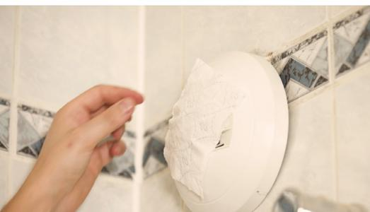
**Pour vérifier qu'une VMC** (ventilation mécanique contrôlée) **fonctionne, posez une feuille de papier toilette sur les grilles de sortie.** Elle doit normalement tenir seule avec l'aspiration de l'air.
