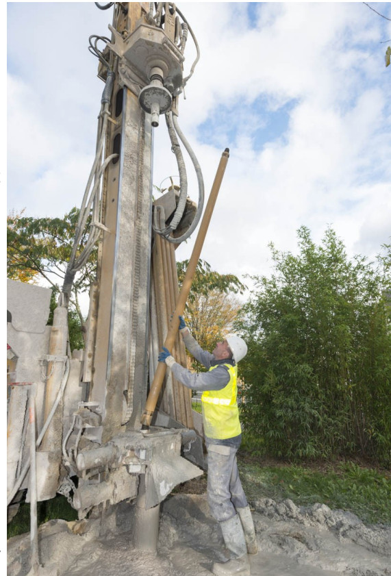
Des forages à plus de 100 mètres pour aller puiser la chaleur dans la terre.
