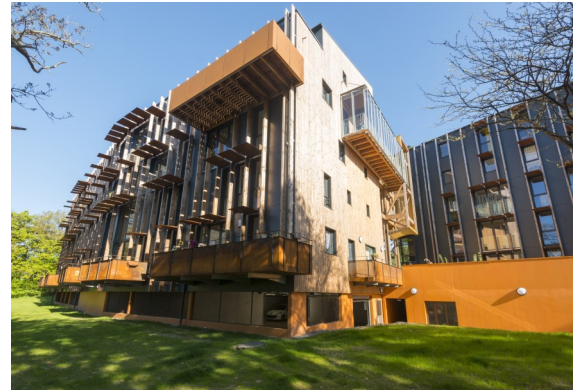
Le Grand Carcouët, premier bâtiment à énergie positive pour du logement locatif social sur le grand Ouest.
